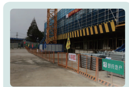
定型化欄桿重複利用 Reusable standardized guardrails
